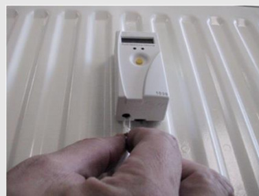
7-15 EINSETZEN DER PLOMBE
