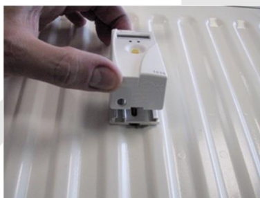
7-14 MONTAGE EHKV AUF WÄRMELEITER
