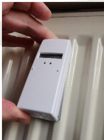
6-14 MONTAGE EHKV AUF WÄRMELEITER
