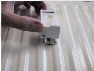
8-14 MONTAGE EHKV AUF WÄRMELEITER
