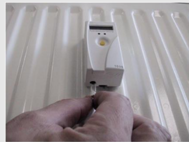
8-15 EINSETZEN DER PLOMBE
